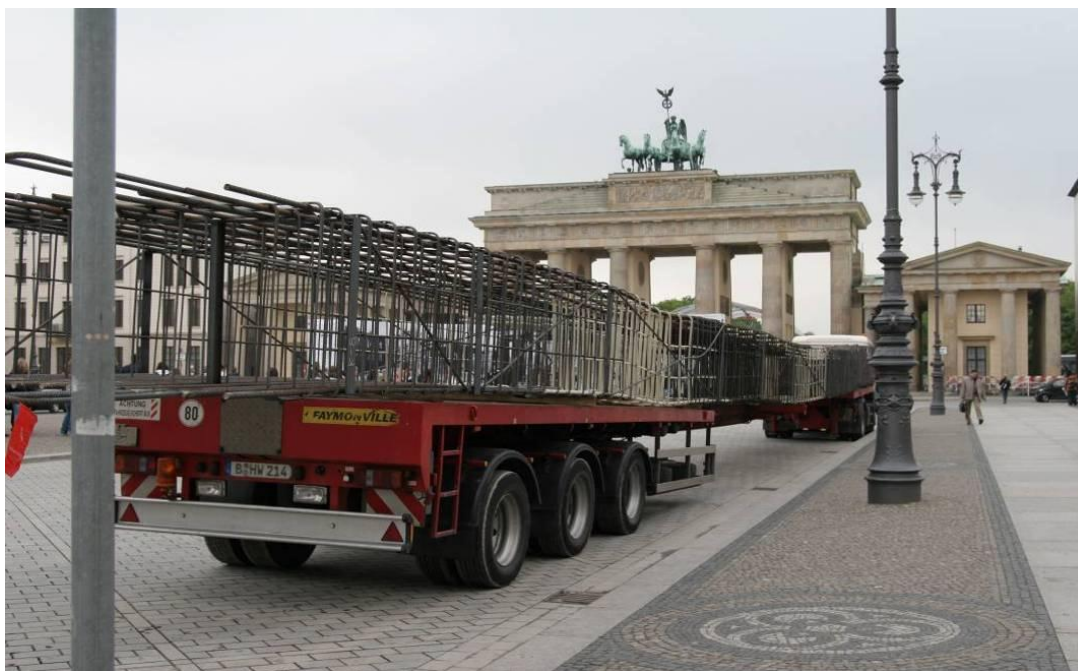
Линия U5 Берлин, Германия, 2007 Армирование в зонах прохождения Микро-ТБМ
