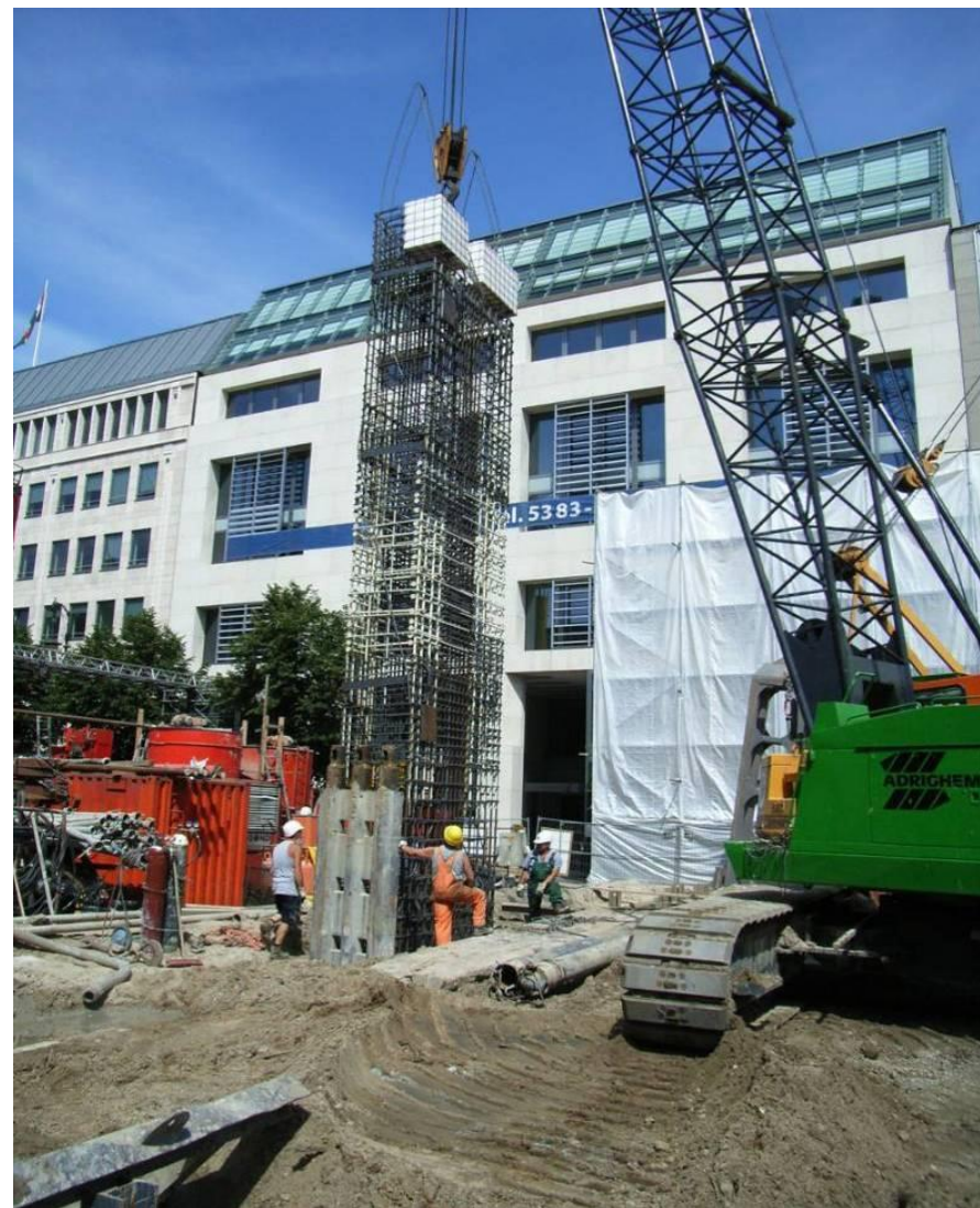
Линия U5 Берлин, Германия, 2007 Армирование в зонах прохождения Микро-ТБМ
